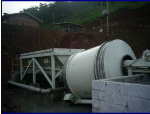
Reciclador de concreto
