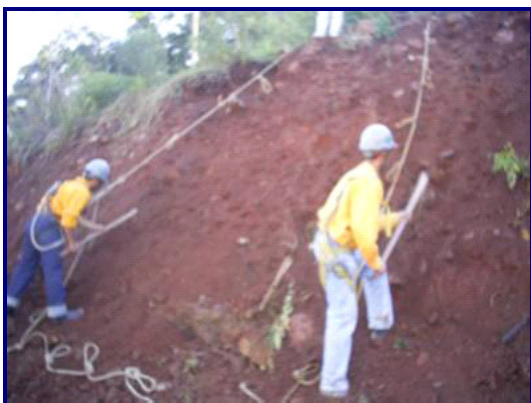
Recuperação de talude ME – abertura de covas
