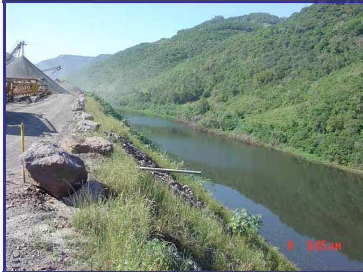
talude do britador
