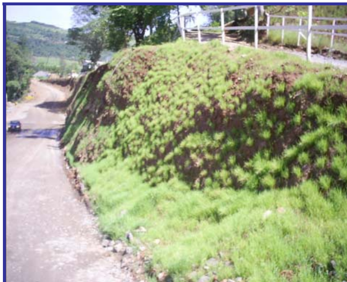
talude da Ponte ME - utilização brizantha, cornichão, ervilhaca.
