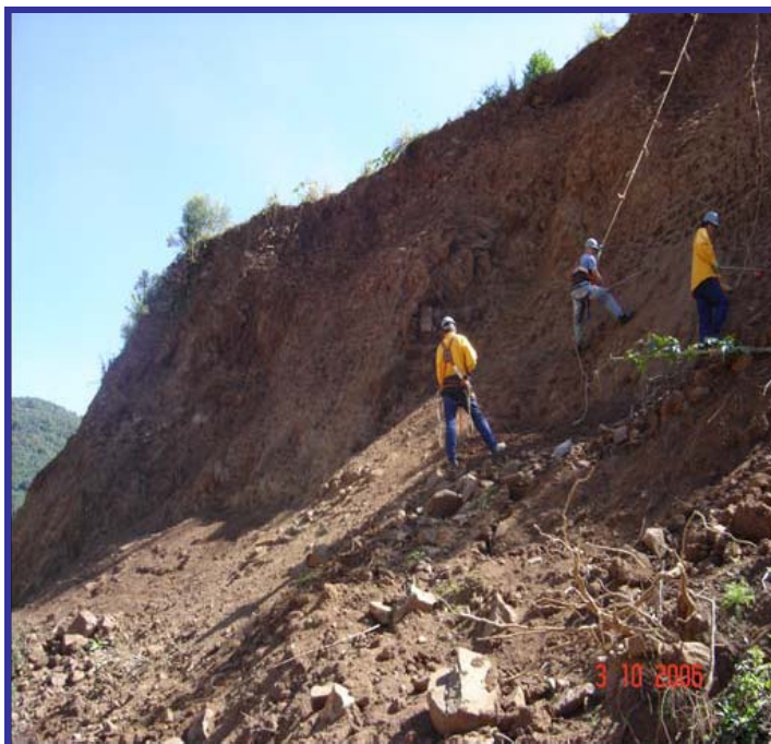
talude acesso ao vertedouro – utilização de brizantha, cornichão, ervilhaca
