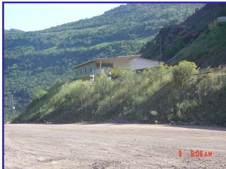
talude do refeitório
