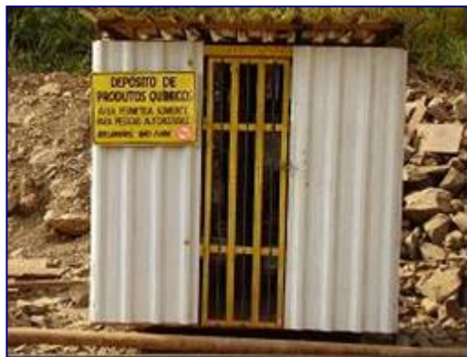
Deposito de produtos químicos
