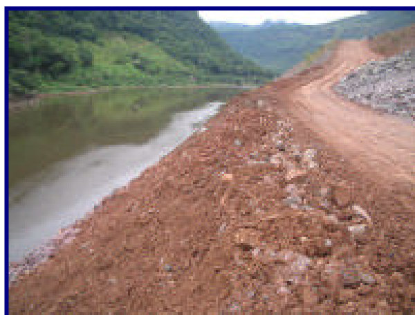
Recuperação do talude ao longo do pátio de ferro
