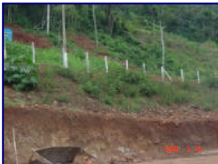
Regeneração natural do talude do reservatório de água industrial - Margem Esquerda
