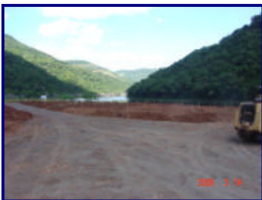
Recuperação com solo orgânico no antigo depósito de brita
