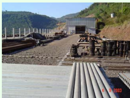
A ORGANIZAÇÃO POSSÍVEL EM QUALQUER FASE DA OBRA
